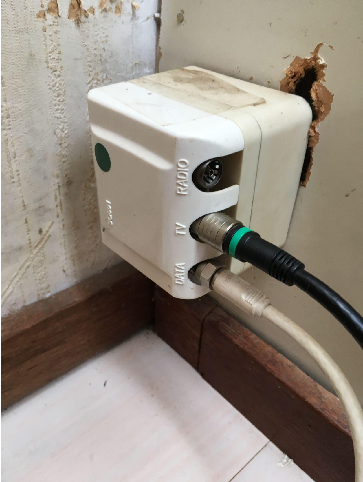
Witte kabel gaat rechtstreeks naar de Connect-Box. Zwarte kabel gaat naar TV.
